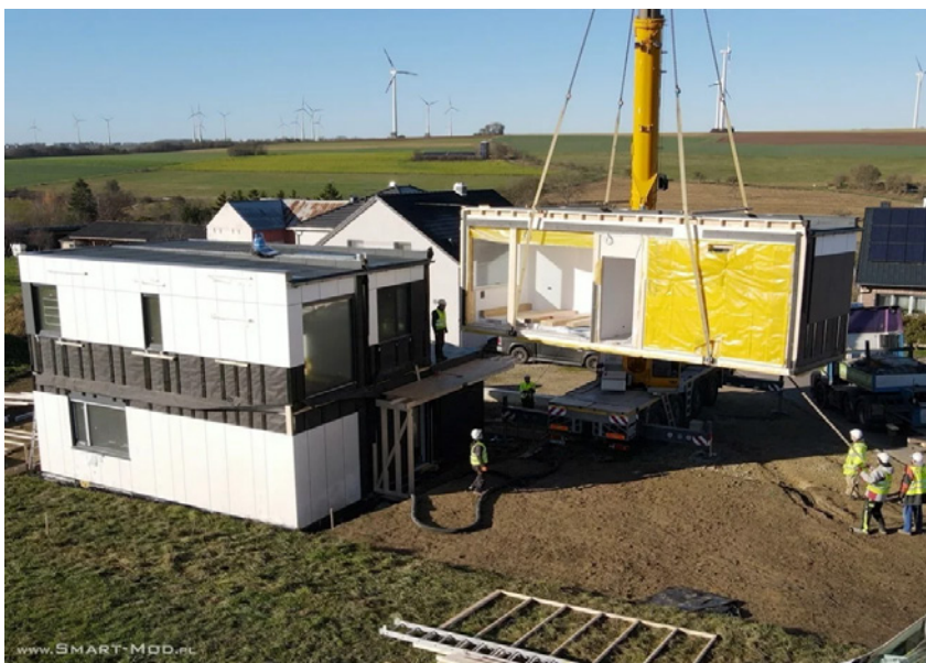
Rys. 14. Montaż modułów https://smart-mod.pl/domy-modulowe/
