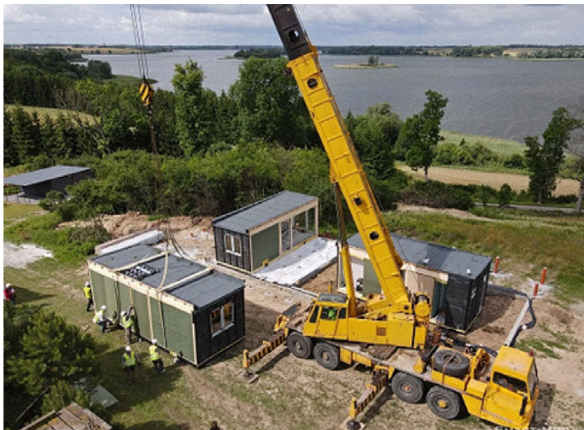
Rys. 13. Montaż modułów https://smart-mod.pl/domy-modulowe/
