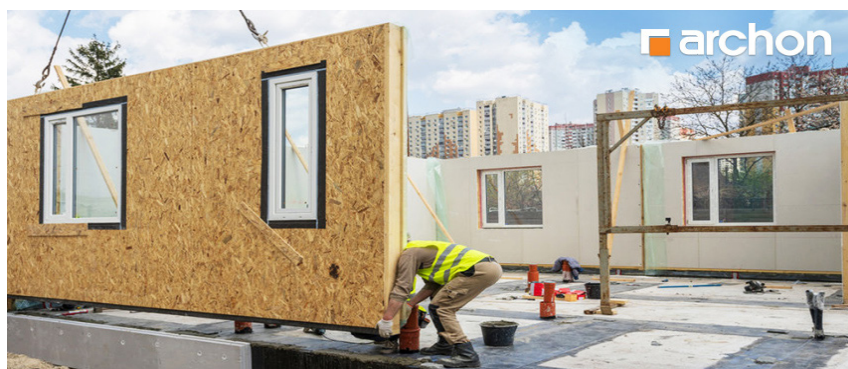
Rys. 8. Elementy prefabrykowane do domu modułowego (ściany z wykończeniem i oknami) https://www.archon.pl/domy-modulowe-art-10475
